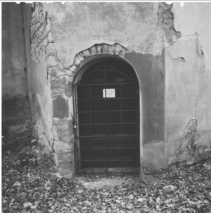
Detail vstupu západní předsíně v pohledu od západu. Foto: 1987, sbírka negativů NPÚ ÚOP v Ústí n. L., sign. 95632.
