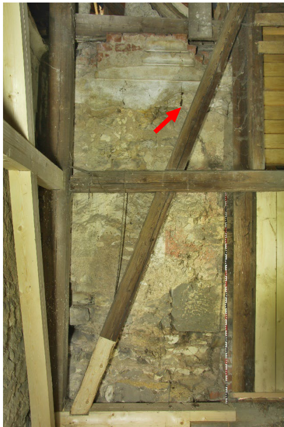
Pohled od východu z interiéru zvonice na severní úsek východního průčelí lodi s dochovaným fragmentem omítkové úpravy s iluzivním červeně malovaným kvádrováním v nároží. Šipkou je označena poloha fragmentu středověké římsy lodi. Foto: Jaroslav Skopec 2018.
