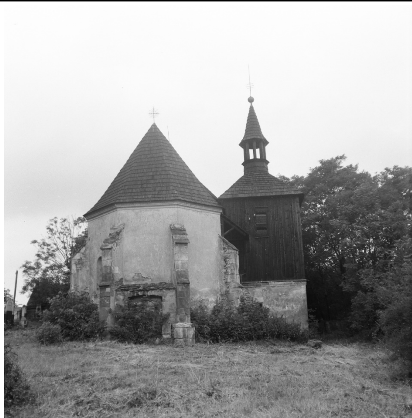
Celkový pohled na kostel od východu. Foto: 1966, sbírka negativů NPÚ ÚOP v Ústí n. L., sign. 57787.
