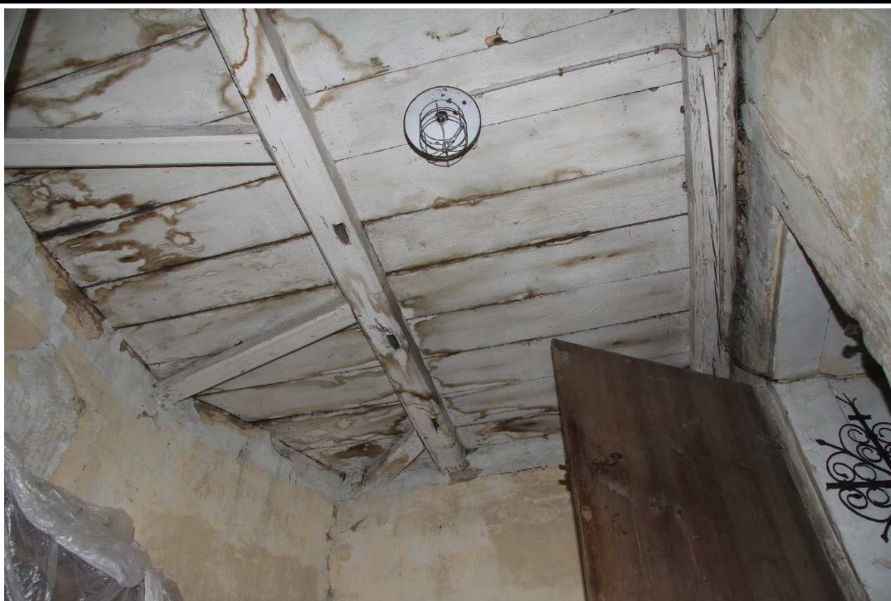
Strop v potře předsíně v pohledu od severovýchodu. Foto: Jaroslav Skopec 2020.
