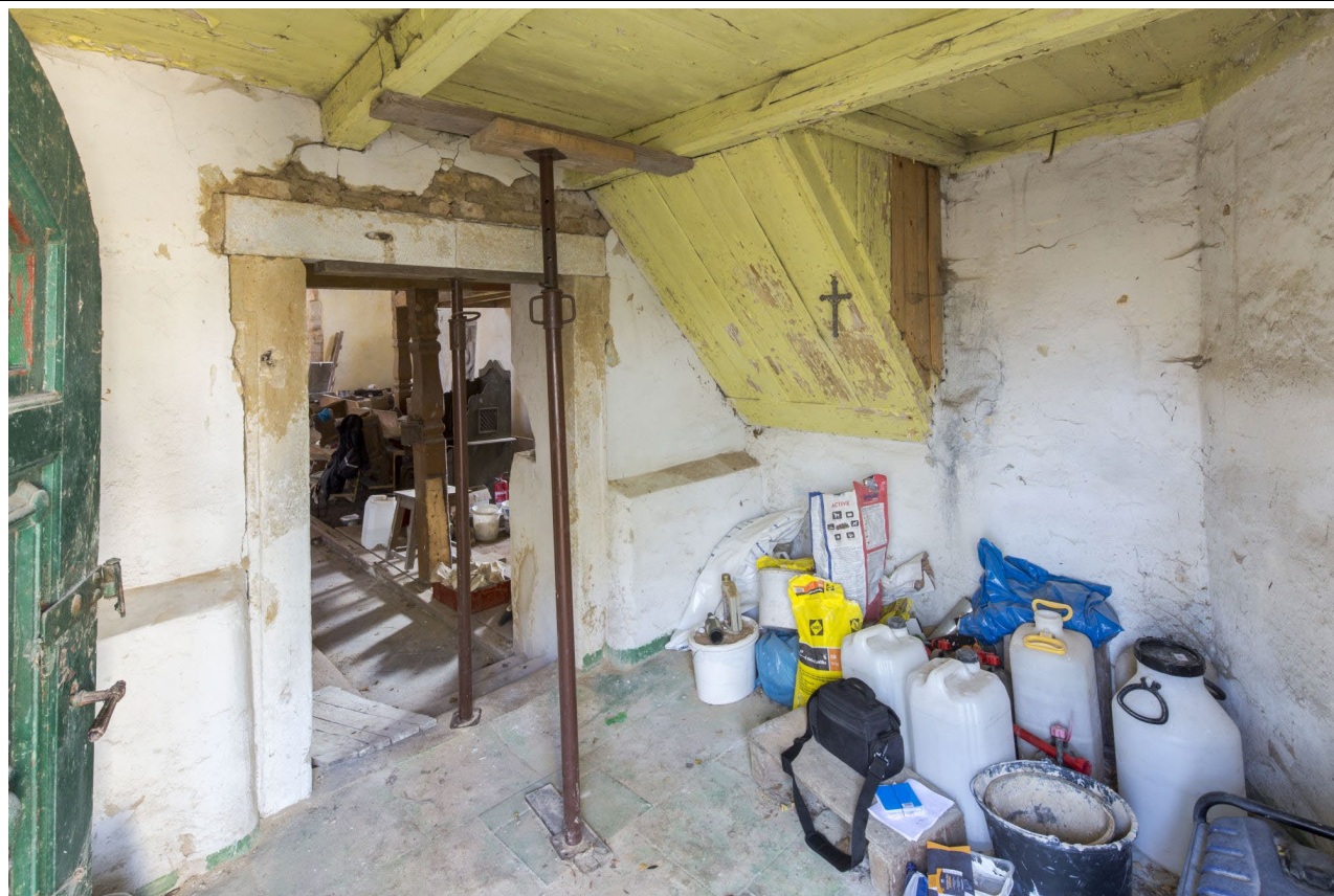
Interiér přízemí předsíně v pohledu od severozápadu. Foto: Marta Pavlíková 2020.
