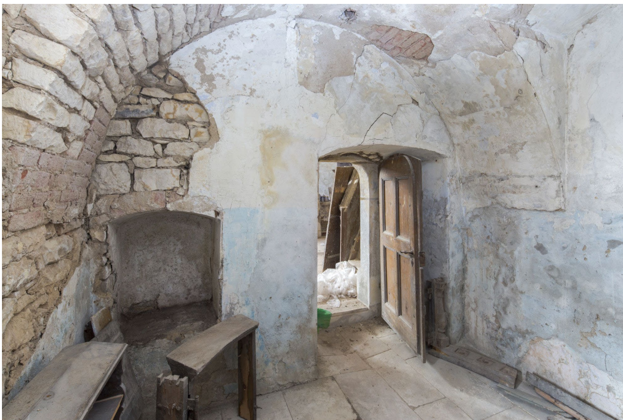
Interiér sakristie v pohledu od severu. Foto: Marta Pavlíková 2020.
