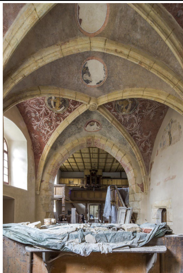
Interiér presbytáře v pohledu od východu. Foto: Marta Pavlíková 2020.
