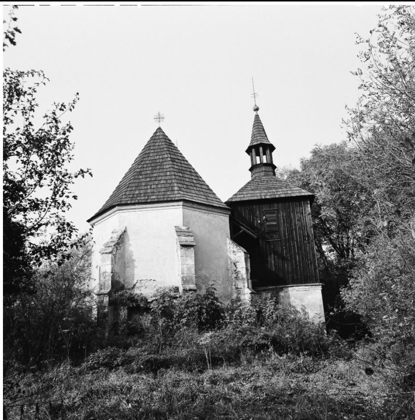
Celkový pohled na kostel od východu. Foto: 1987, sbírka negativů NPÚ ÚOP v Ústí n. L., sign. 95629.
