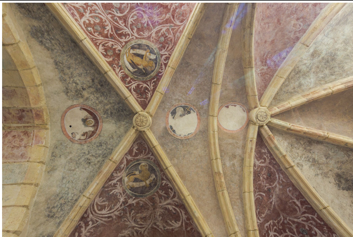
Klenba presbytáře v podhledu. Foto: Marta Pavlíková 2020.
