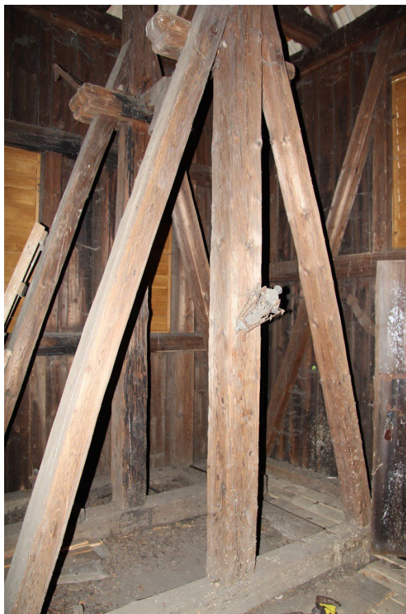
Zvonová stolice zvonice v pohledu od jihozápadu. Foto: Jaroslav Skopec 2018.
