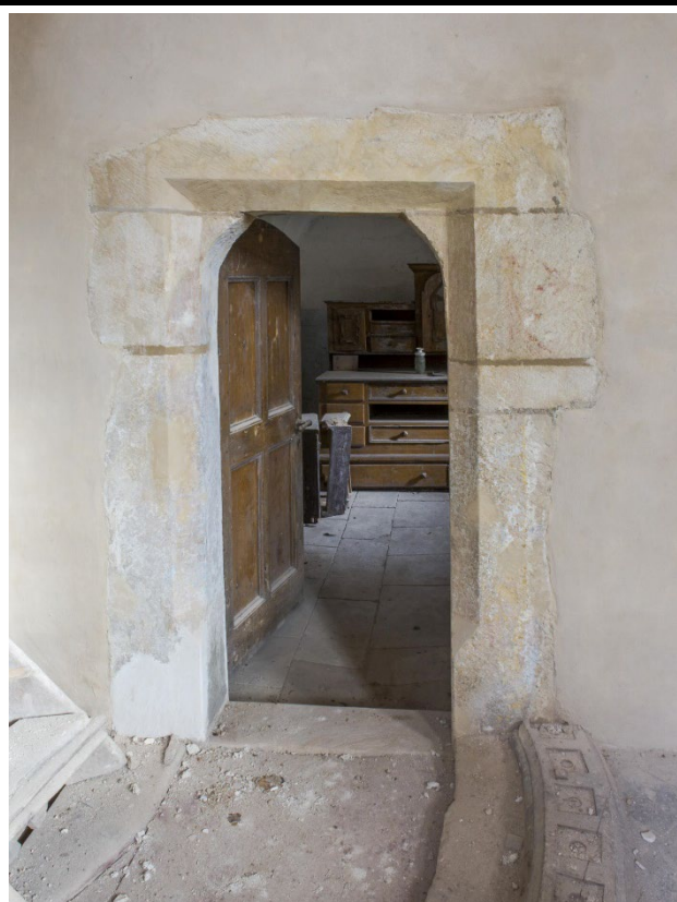
Čelní pohled od jihu na portál vedoucí z presbytáře do sakristie. Foto: Marta Pavlíková 2020.
