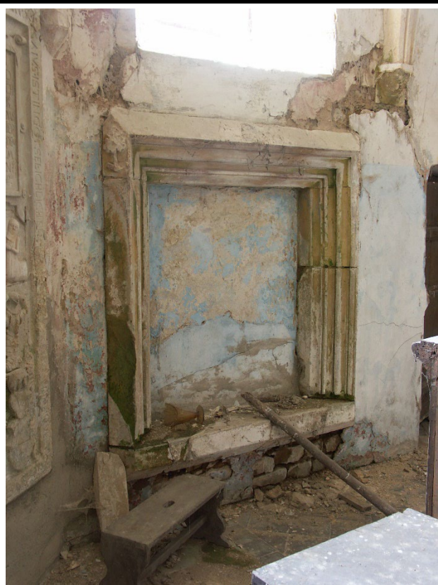
Pohled od severovýchodu na sedile osazené v jižní stěně presbytáře. Foto: Jaroslav Skopec 2008.
