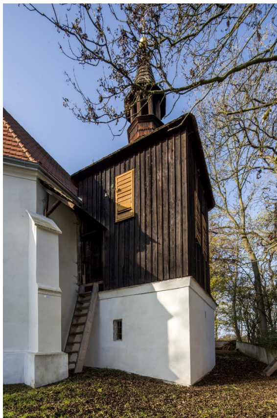
Sakristie se zvonící v pohledu od severovýchodu. Foto: Marta Pavlíková 2020.
