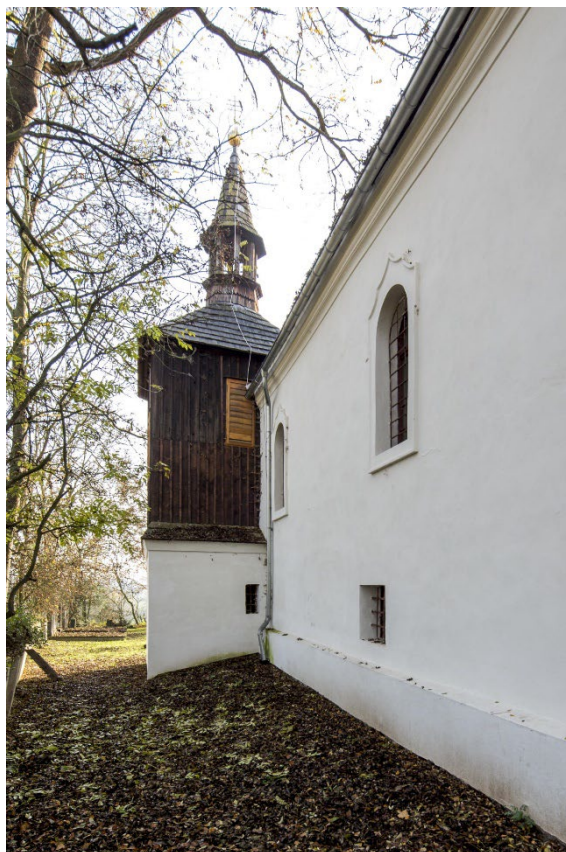
Severní strana kostela v pohledu od severozápadu. Foto: Marta Pavlíková 2020.
