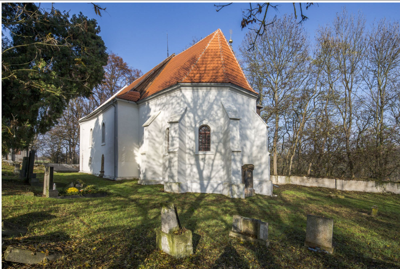
Celkový pohled od jihovýchodu. Foto: Marta Pavlíková 2020.
