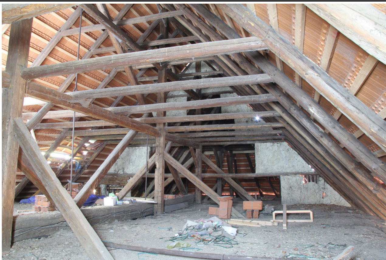
Krov nad lodí v pohledu od jihozápadu. Foto: Jaroslav Skopec 2020.
