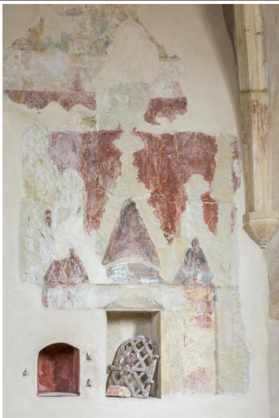
Čelní pohled od jihu na sanktuárium s patrnými odsekanými reliéfy jeho architektury. Foto: Marta Pavlíková 2020.
