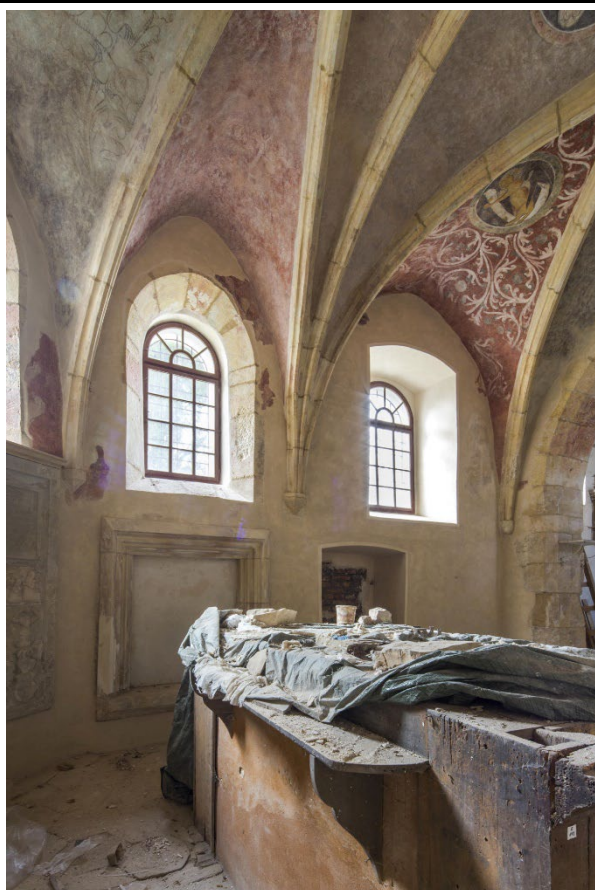
Jižní strana presbytáře v pohledu od severovýchodu. Foto: Marta Pavlíková 2020.
