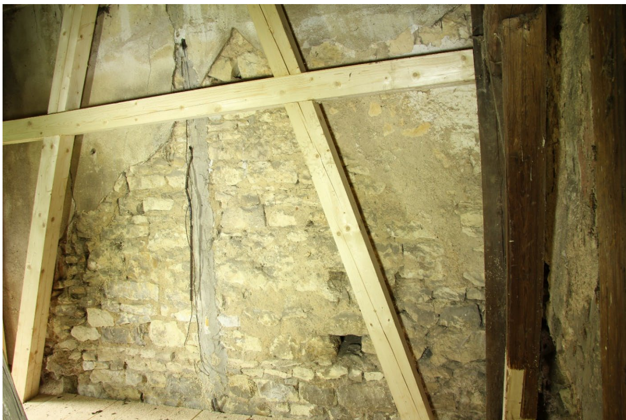
Pohled od severozápadu na exteriérový líc severní stěny presbytáře nacházející se v interiéru zvonice. Na snímku je zřetelný otisk po sedlové střeše sakristie. Foto: Jaroslav Skopec 2018.
