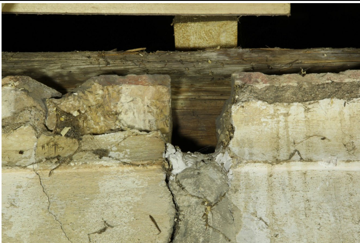
Detail fragmentu středověké římsy na severní straně presbytáře patrné z interiéru zvonice. Foto: Jaroslav Skopec 2018.
