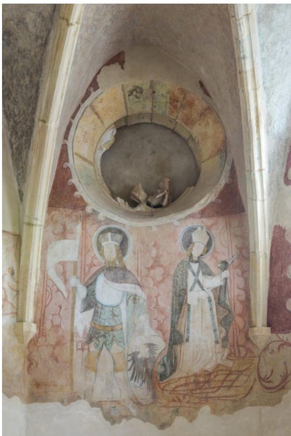
Čelní pohled od západu na východní klenební čelo závěru presbytáře. Foto: Marta Pavlíková 2020.
