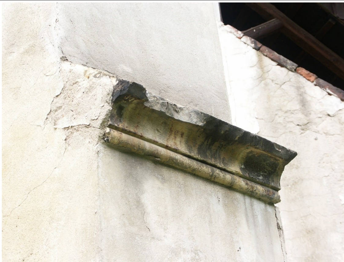
Detail stříšky odsazení východoseverovýchodního opěráku presbytáře. Foto: Jaroslav Skopec 2008.
