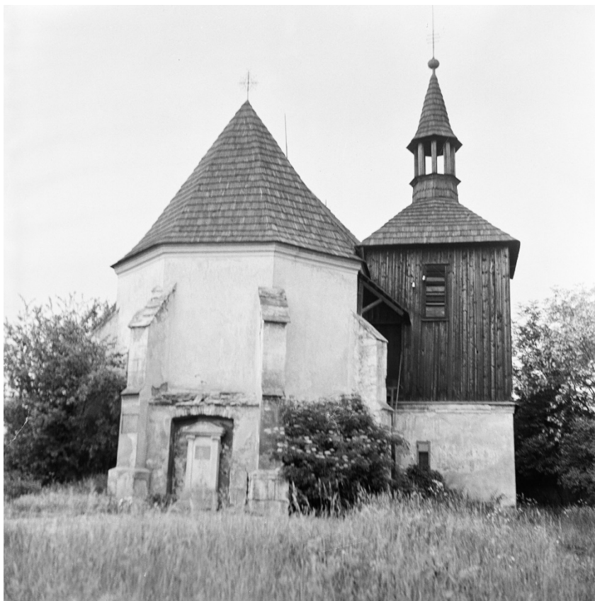
Celkový pohled na kostel od východu. Foto: 1963, sbírka negativů NPÚ ÚOP v Ústí n. L., sign. 9289.
