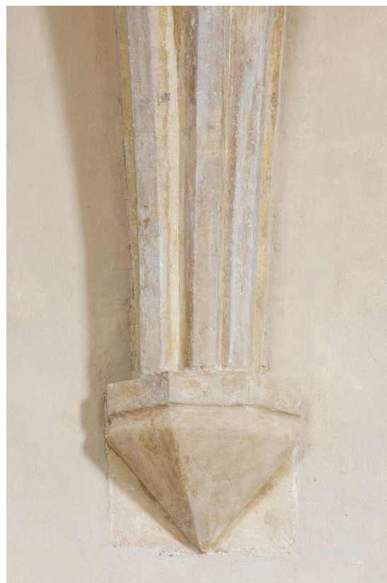
Detail severní konzoly klenby presbytáře. Foto: Marta Pavlíková 2020.
